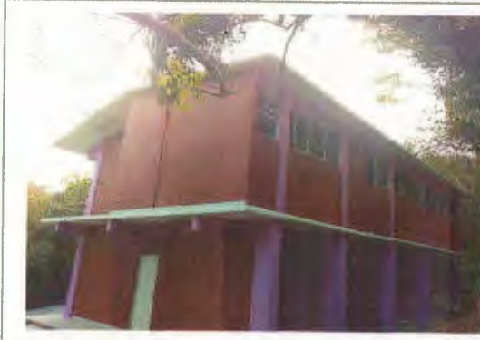
F2: Fachada posterior.
